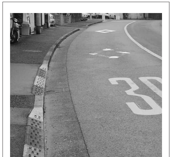
(図5) 自転車は舗装の継ぎ目に沿って走行することを強いられる。道路設置者には配慮の外？
