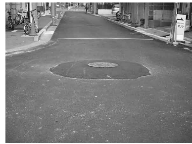
写真3 道路工事中の盛り上がったマンホールの蓋
