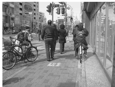
写真11 機能しない「カラー分離」の巻き込み部
