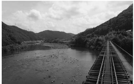
①三江線・式敷駅(広島県安芸高田市)付近 三江線はほぼ全線にわたって江の川沿いを走る。沿線には平地が少なく、わずかな土地に田畑が営まれている。
