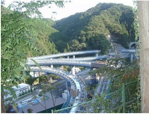
高尾山トンネル南孔口の工事現場
