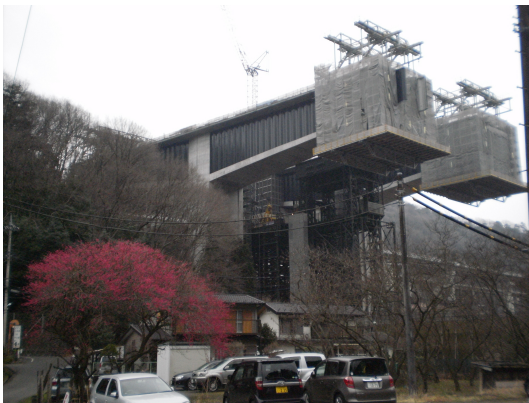
高尾山トンネル北孔口の工事現場
