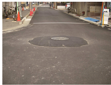
写真3 道路工事中の盛り上がったマンホールの蓋
