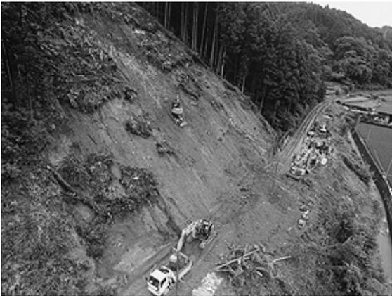
写真2 内子線 斜面崩壊復旧工事の様子(7月15日)
